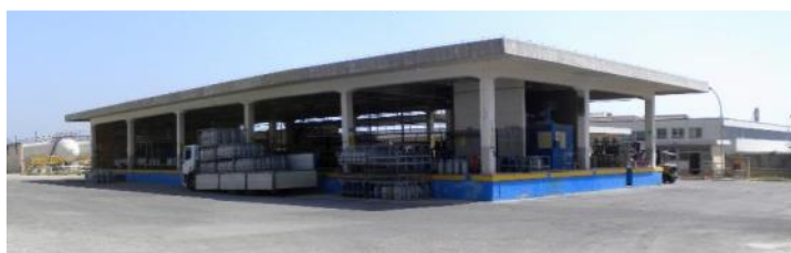
Lo stabilimento EnerGas
